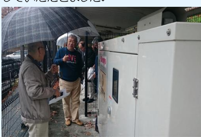
朝日プラザ自主防災委員会の秋本氏に敷地内に設置された発電機の説明をしていただきました。(既存の駐車場に設置)
