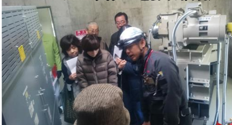
エレベーター本体の電源切訓練
